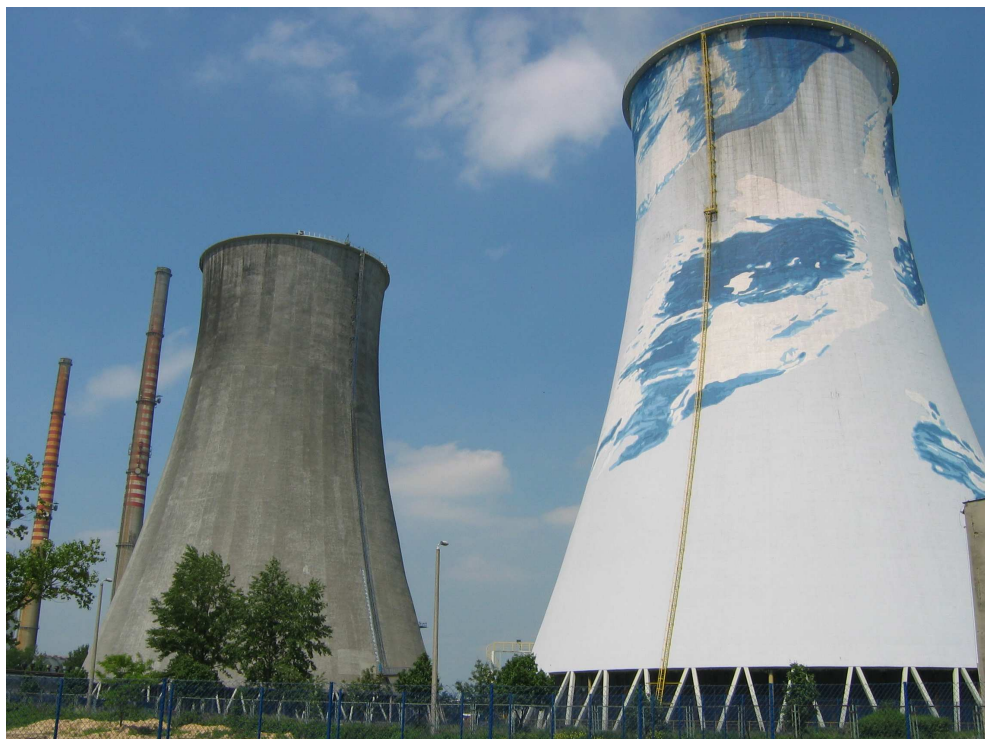
Rys. 1. Zdjęcie kominów EC KRAKÓW – widok od południowego - wschodu (fot. A. Zagrodzka)
